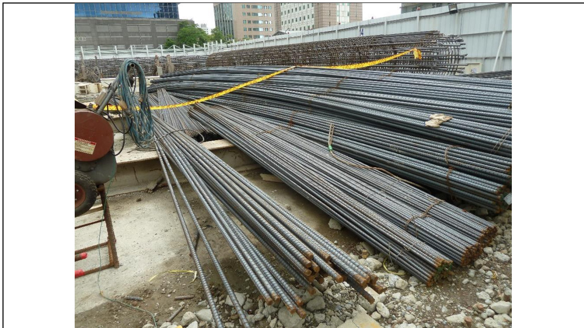
說明一 陳罹災者於鋼筋堆置區進行鋼筋吊掛作業。
