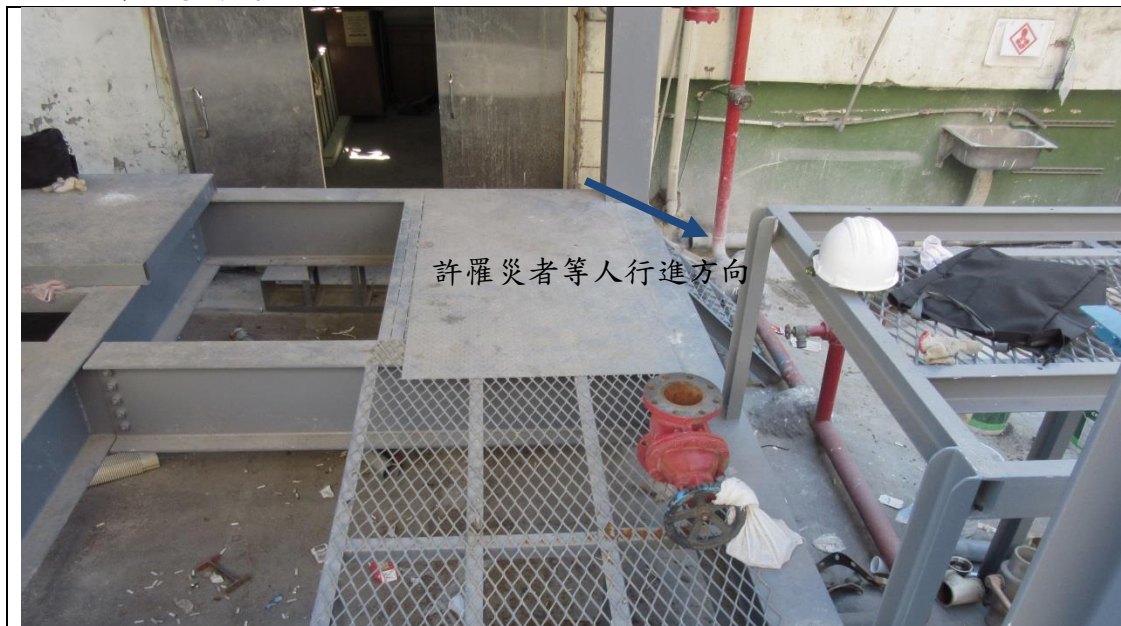
說明一 屋頂水箱平臺。
